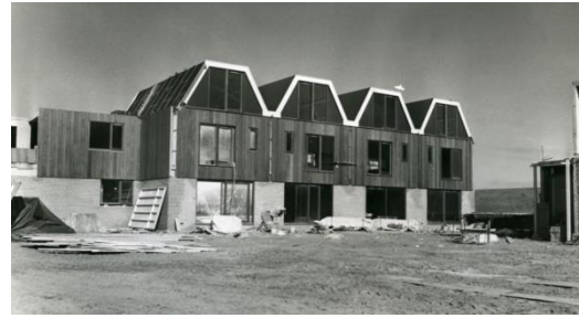
De Archipel in aanbouw, 1976.
